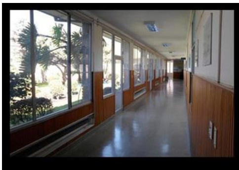
Imagen 9: Pasillos del área de oficinas y aulas
